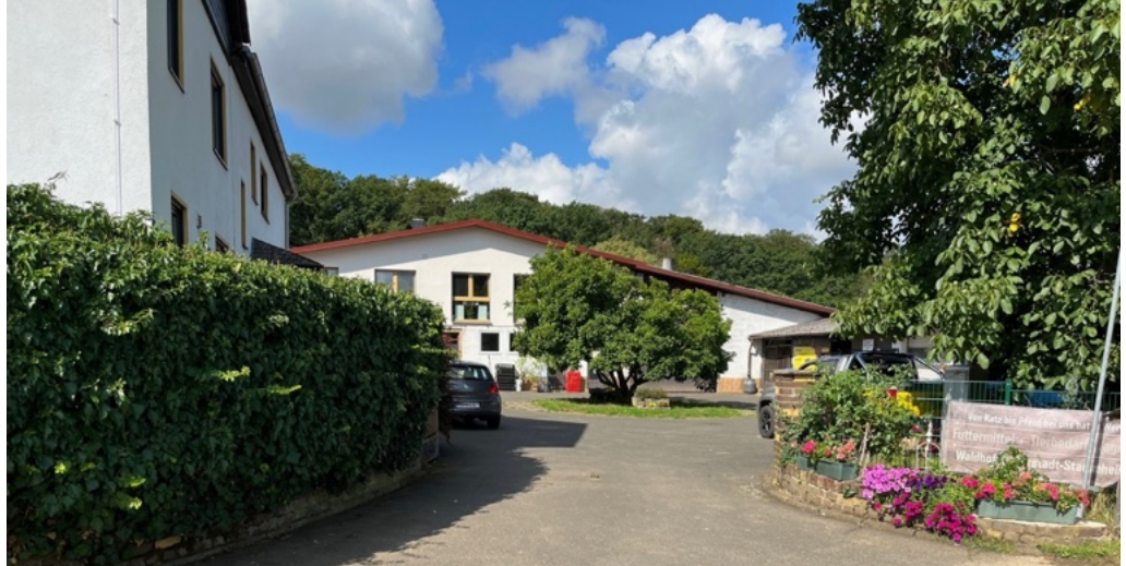
Zufahrt zum Aussiedlerhof / Parzelle 187 – links das Wohngebäude, hinten das Betriebsgebäude – im EG Stallungen und Lager, Teilbereich im DG mit Wohnung
