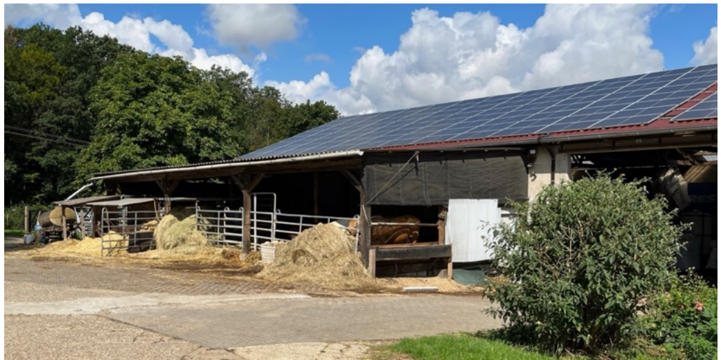
Beispiel für etliche ähnliche Situationen: Ergänzungen des Hallengebäudes auf der Parzelle 188/1 durch einen offenen Unterstand für das Vieh
